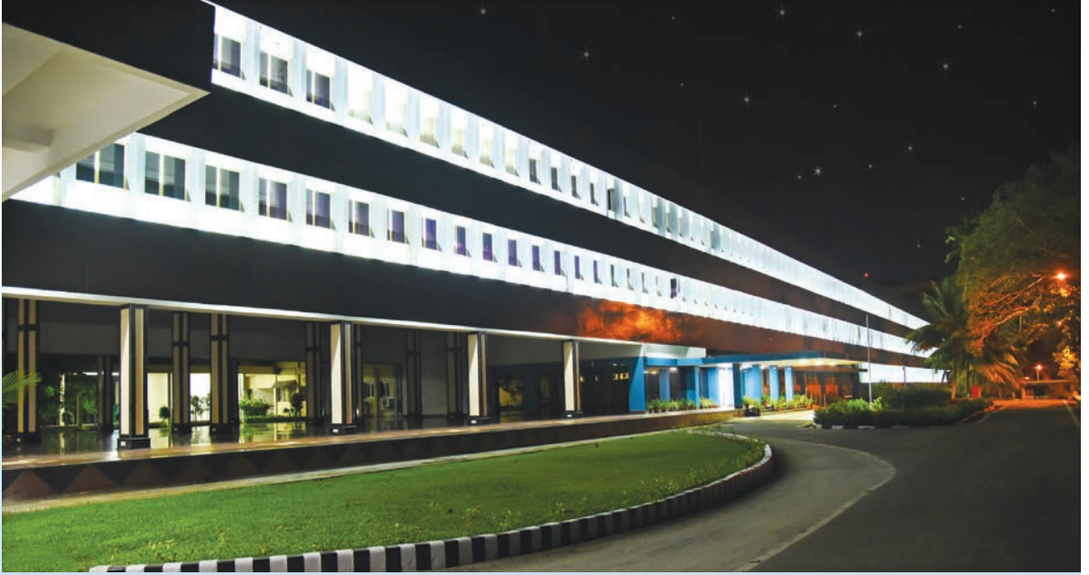
वेली रेंज कॉम्प्लेक्स में वी.एस.एस.सी. मुख्य भवन
