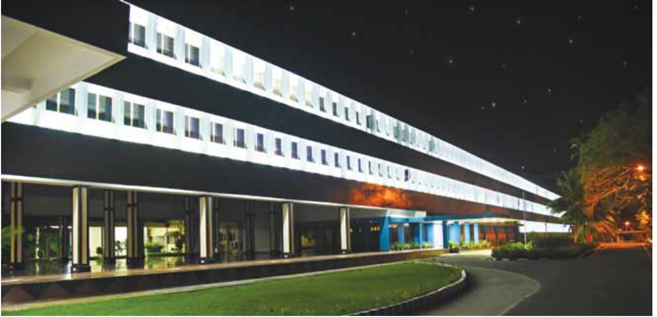
वेली रेंज कॉम्प्लेक्स में वी.एस.एस.सी. मुख्य भवन
