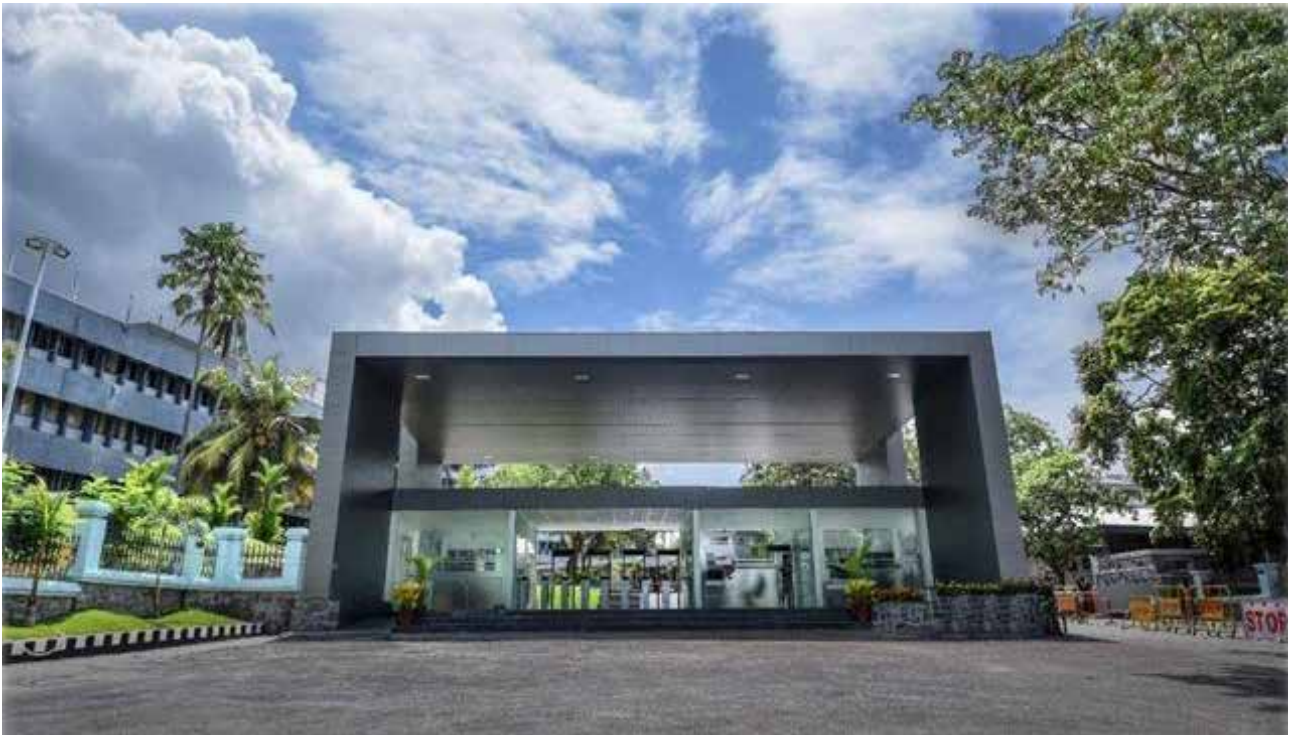
वेली रेंज काम्प्लेक्स में वी.एस.एस.सी. मुख्य भवन
