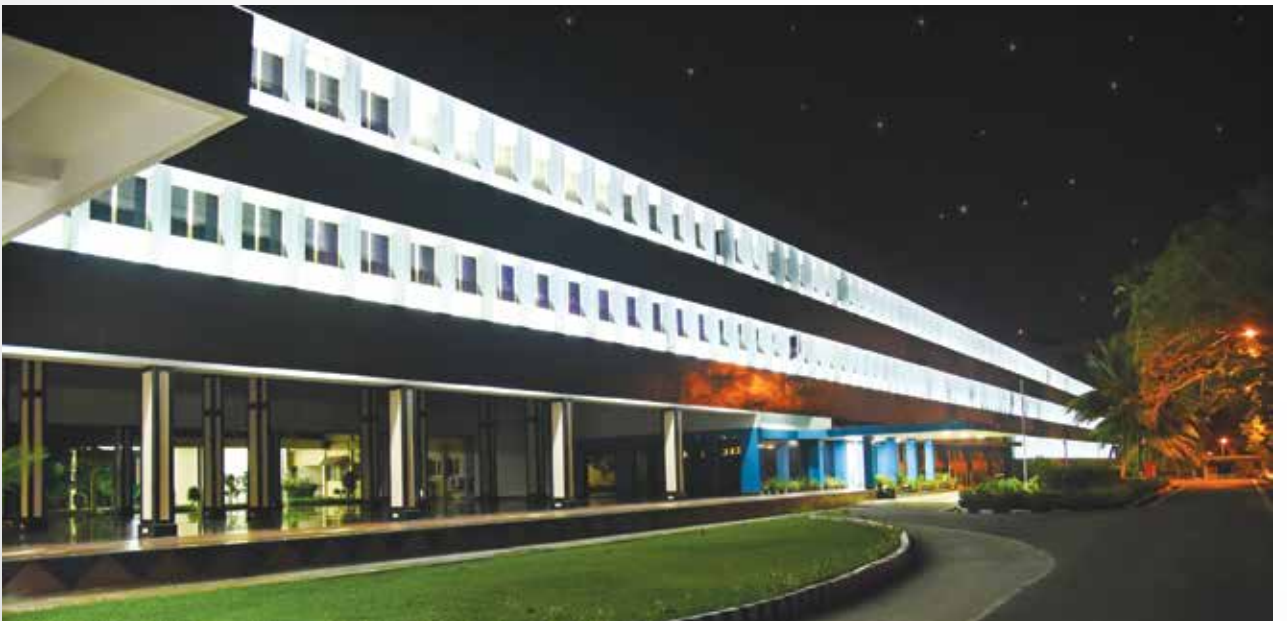
वेली रेंज कॉम्प्लेक्स में वी.एस.एस.सी. का मुख्य भवन
