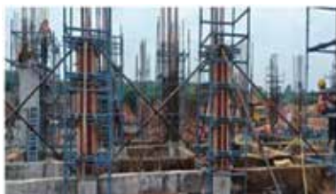
एस.एस.एल.वी. प्रमोचन पैड का निर्माण
