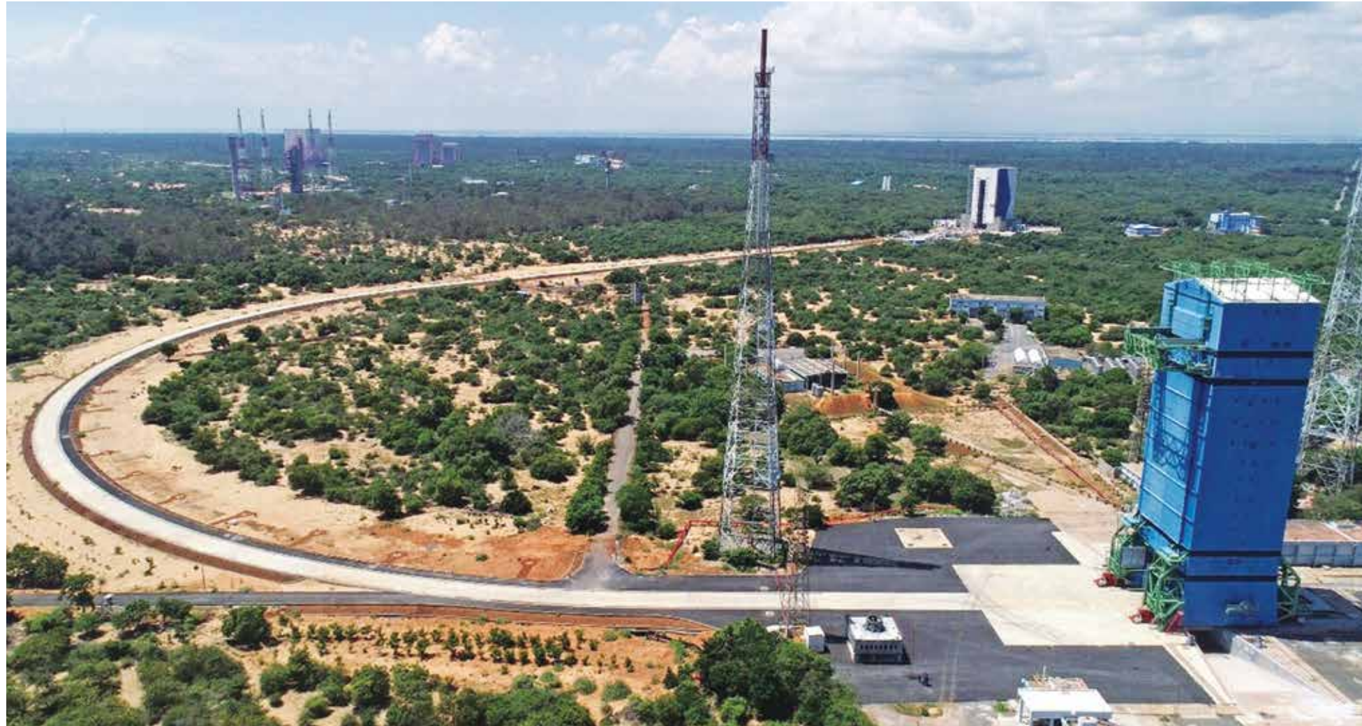
पीआईएफ के साथ प्रथम प्रक्षेपण स्थल भवन सुविधा First Launch Pad Complex Facilities along with PIF
