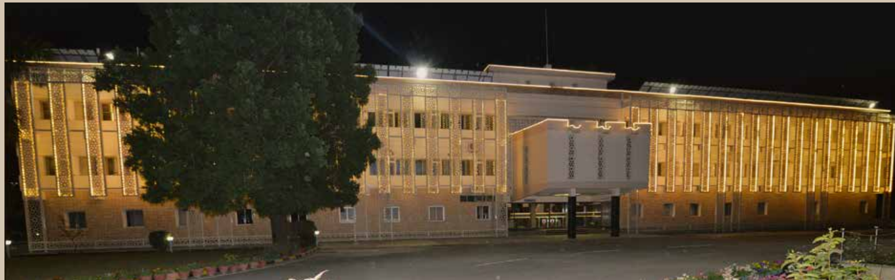
आईआईआरएस मुख्य भवन IIRS Main Building
