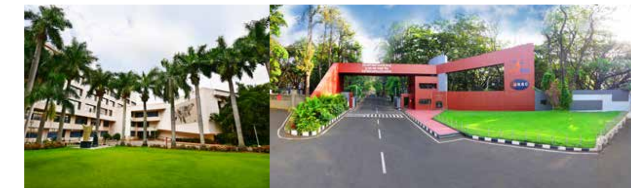
यू.आर.एस.सी. मुख्य भवन URSC Main Building
