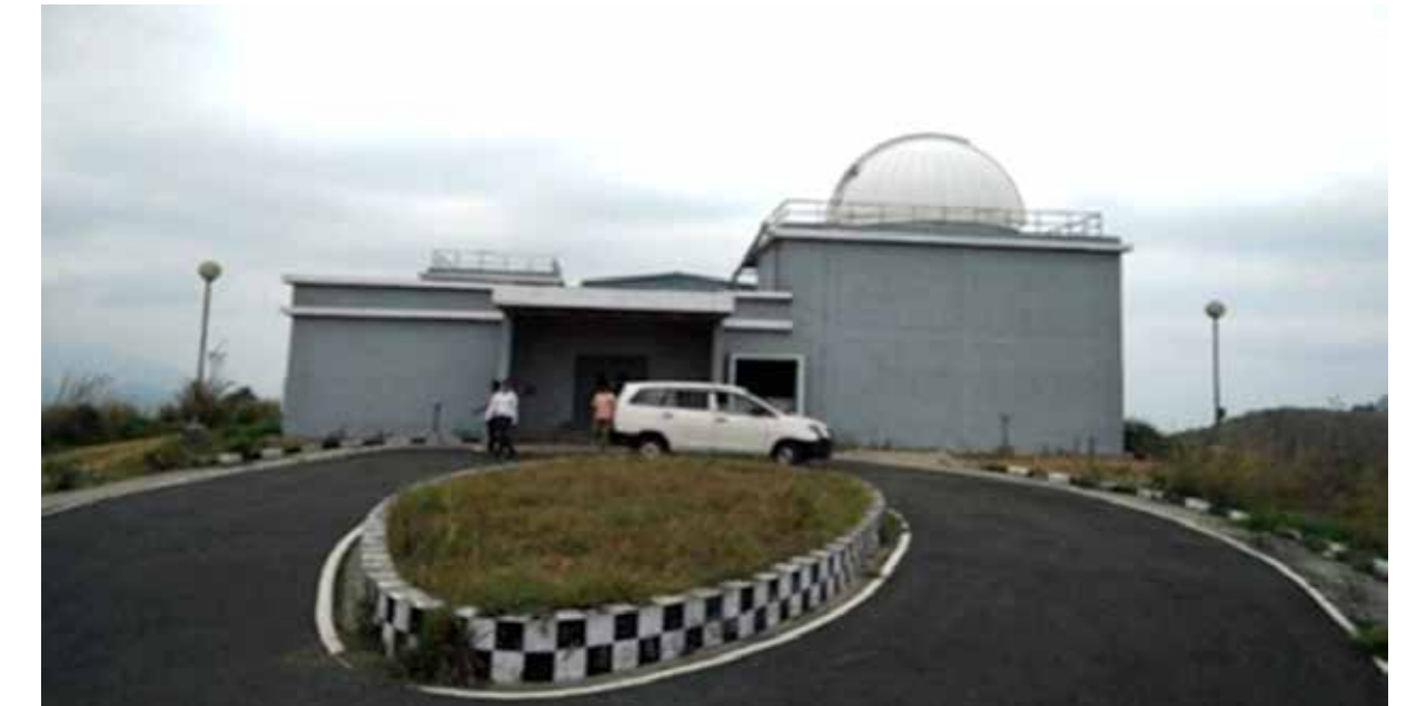
एसपीआरओसी सुविधा, पोनमुडी, केरल SPROC Facility Ponnemudi, Kerala
