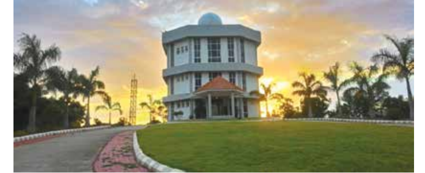
एन.ए.आर.एल. में एक्स.-बैंड रेडार भवन X-band Radar Building at NARL
