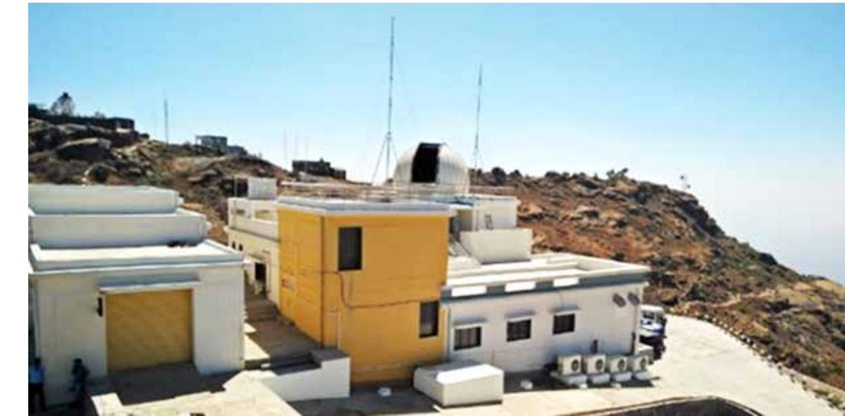
एसपीआरओसी सुविधा, माउंट आबू, राजस्थान SPROC Facility Mt.Abu, Rajasthan
