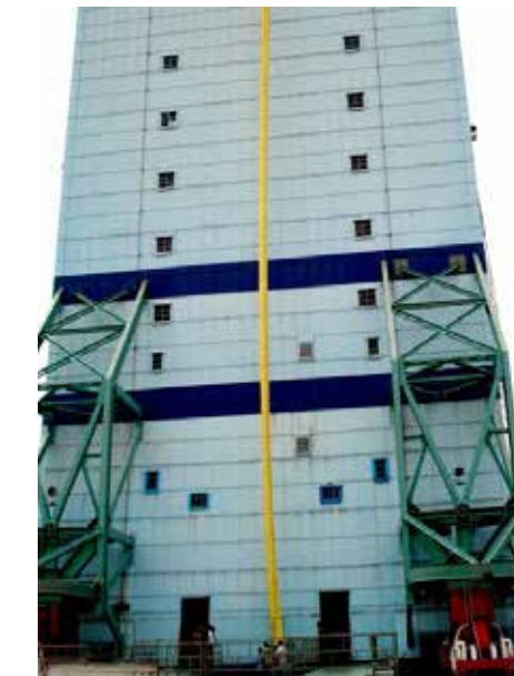
उच्च चुंगता आपातकालीन निकास श्यूट (पीला रंग) High Altitude Emergency Escape Chute (Yellow colour)
